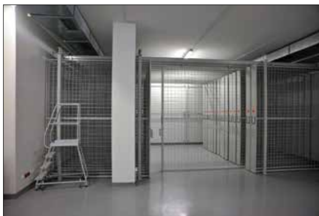
▲ Obr. 9: Výsuvné závěsné stěny pro depozitární uložení obrazů
