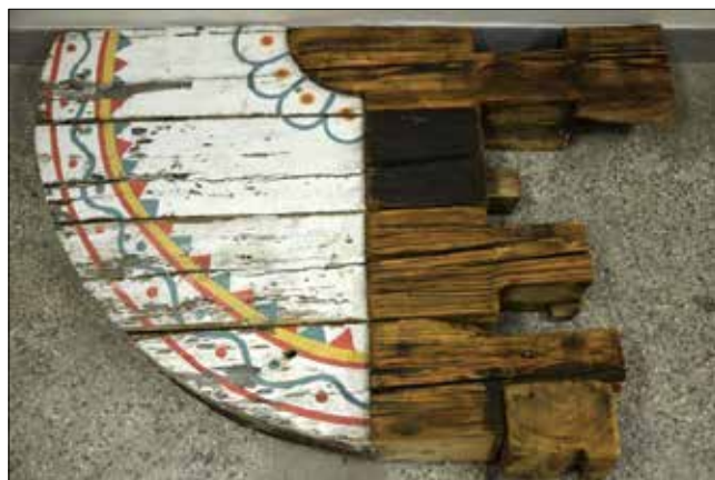
Obr. 4. Levá půlkruhová konzola nad vstupem do jídelny. Foto Luděk Dvořák / Left-hand semi-circular cantilever above the entrance to the dining hall. Photo taken by Luděk Dvořák
