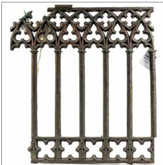
Obr. 1a. Fragment litinového zábradlí Místodržitelského letohrádku v nálezovém stavu / Fragment of the cast-iron railing of Governor's Summer Residence in Prague before restoration
