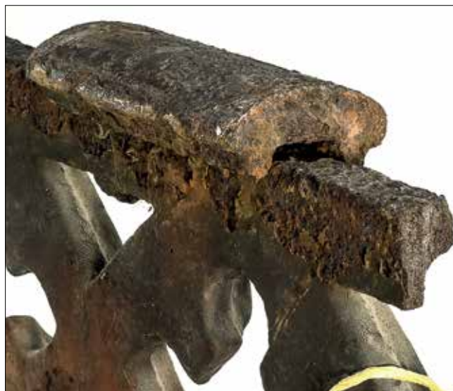
Obr. 1b. Dochovaný zbytek madla zábradlí / Small part of the original handle
