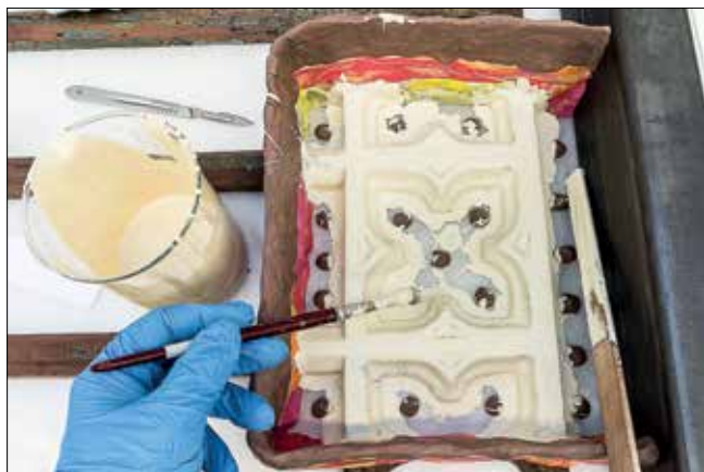
Obr. 5a. Výroba lukoprenové formy pro modely chybějící části dekoru na vhodném místě originálu / Manufacturing of silicone rubber mold for the missing decor parts models in the matching place of the original
