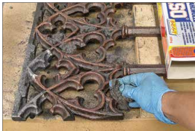
Obr. 5f. Odstraňování nezreagovaných přebytků taninu před druhým nátěrem pomocí ocelové vlny / Removal of unreacted tannin excess prior to second tannin application by steel wool
