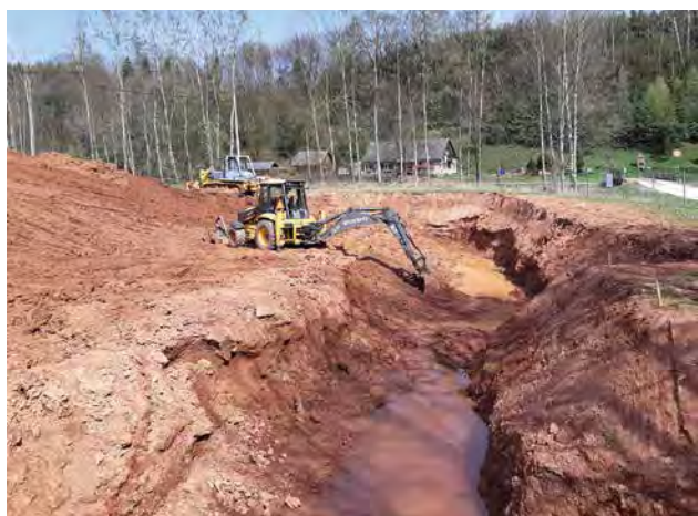
Obr. 7 Dolní Olešnice – příprava těžby 2019
