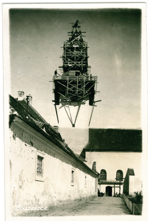
Obr. 1 Oprava kostelní věže v roce 1935, fotografie Karla Chrasta, která byla součástí nálezů / Reconstruction of the church tower in 1935, photo by Karel Chrast, which was part of the find
